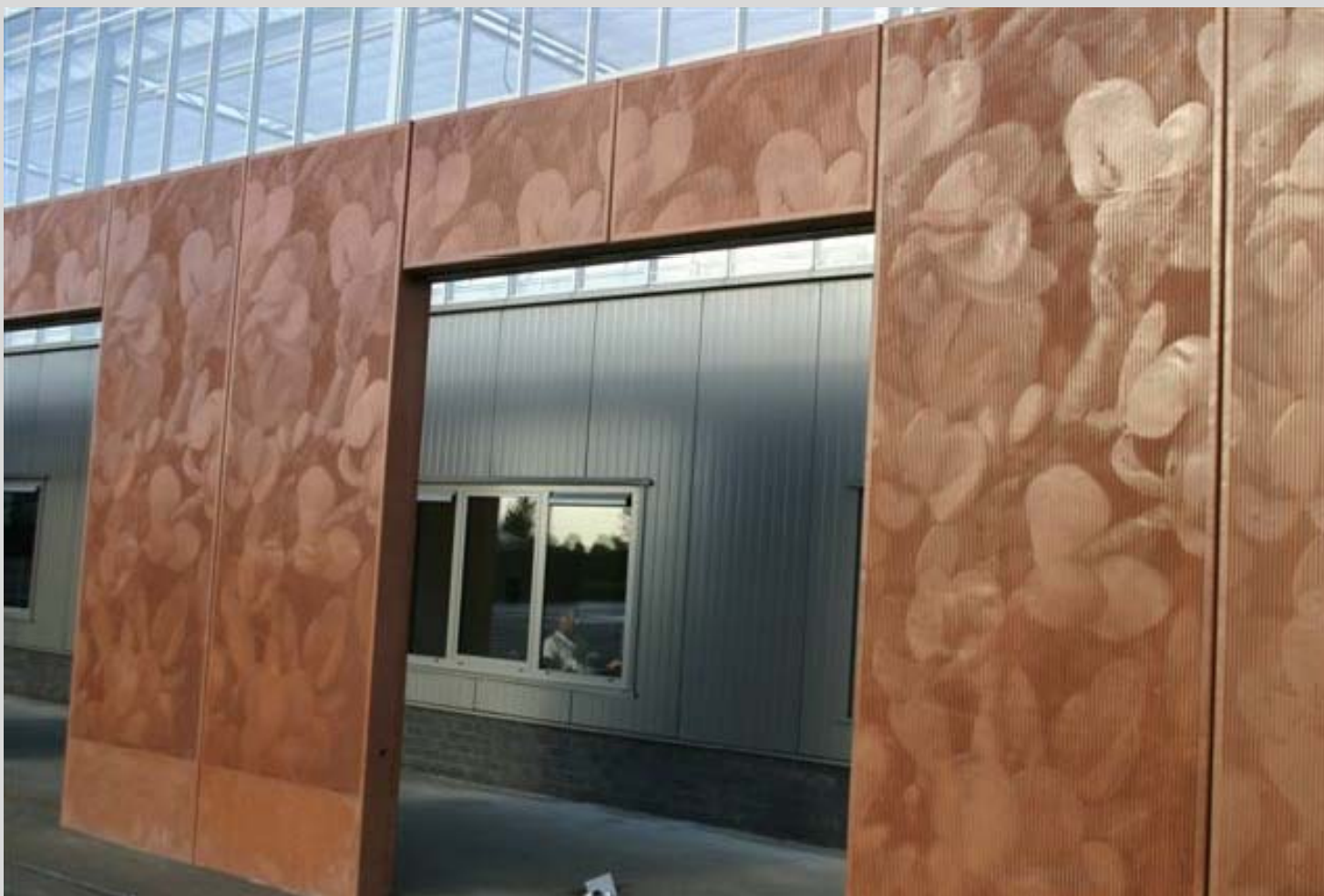
Igazgatósági épület Ovata, Hollandia
