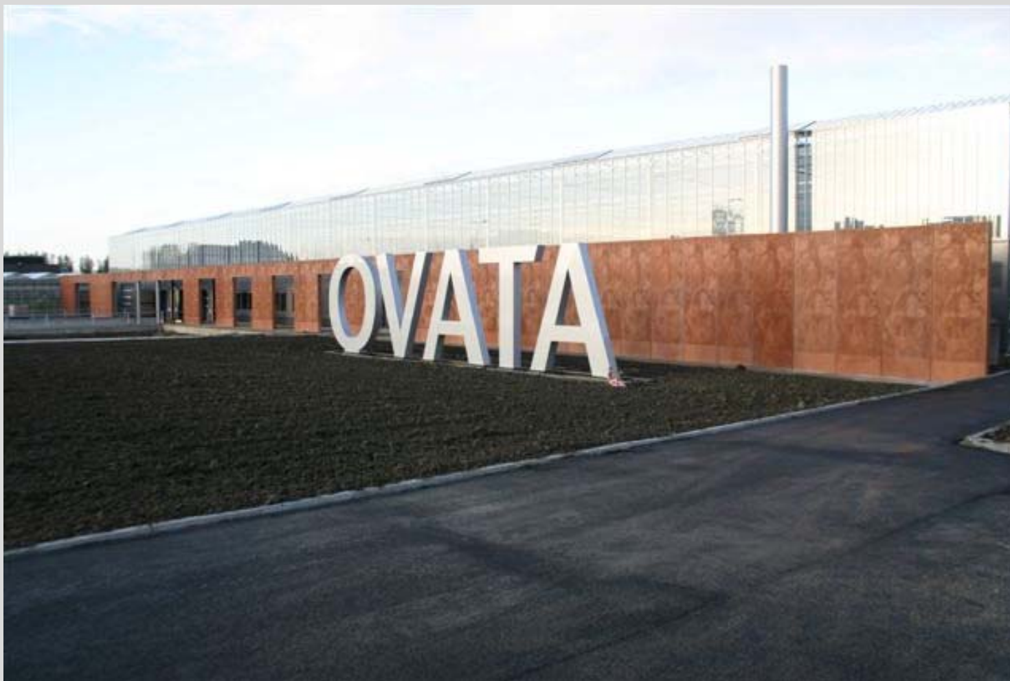
Igazgatósági épület Ovata, Hollandia
