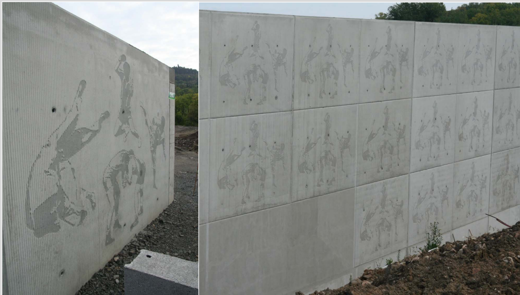
Sportcsarnok, Clermont Ferrand, Franciaország, Elkészült betonelemek
