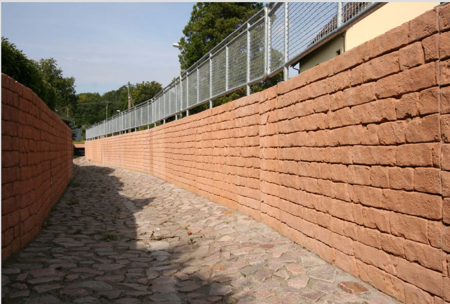
Árvízvédelmi fal, Brand-Erbisdorf, Németország, 2/158 Auvergne
